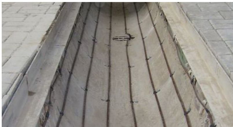
Рис. 5а – Пример устройства защиты лотка от обледенения.
